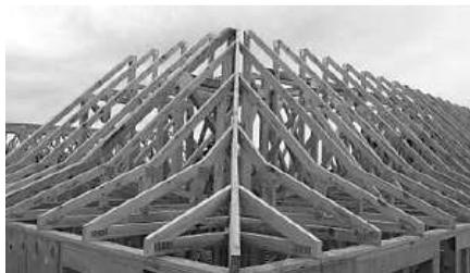
**Рисунок 2 – Конструкция крыши с приподнятыми краями**
